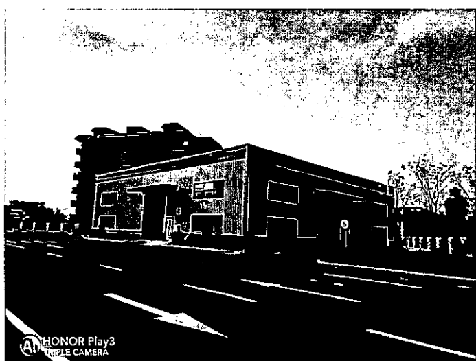
固体废物贮存（处置）场所远照
